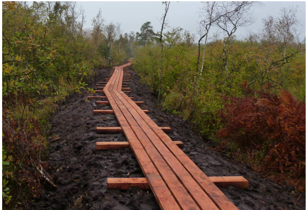
Figur 21. Eksempel på en simpel boardwalk bestående af en 0,6 m bred plankebro af Douglasgran lagt på strøer igennem højmosen Horreby Lyng på Falster.
