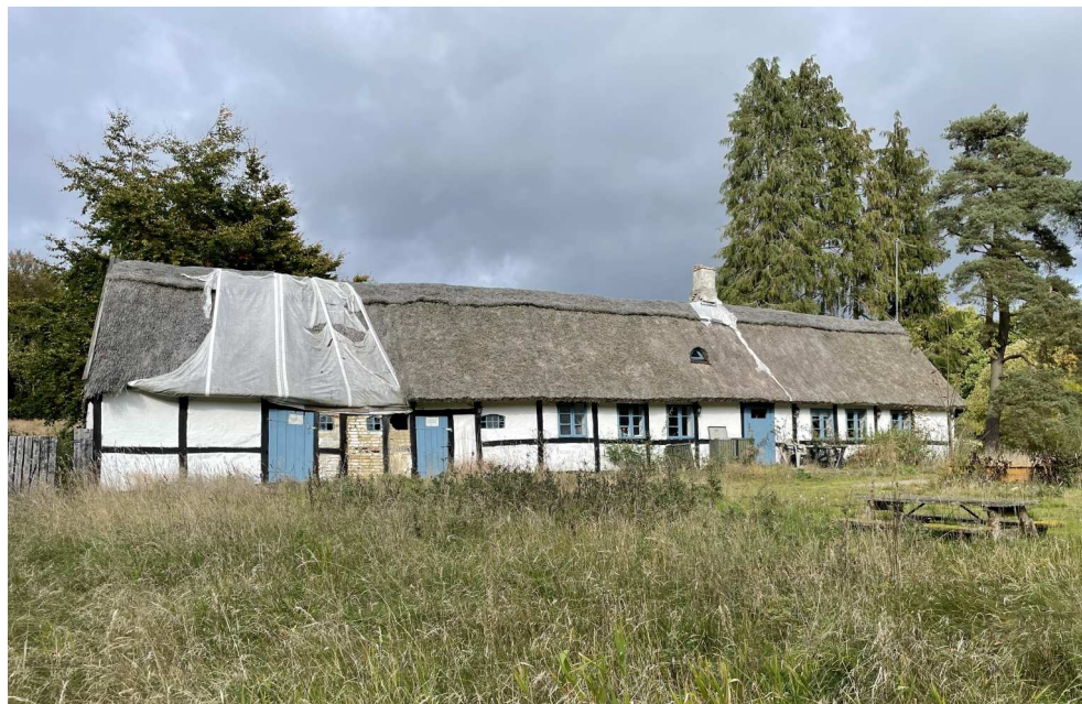
Figur 5. Den stråttækkede bindingsværksejendom Hundeklemmen er en tidligere skovløberbolig og er angiveligt fra 1877, men er måske ældre. Bord-bænkesættet ses til højre i oktober 2022.
