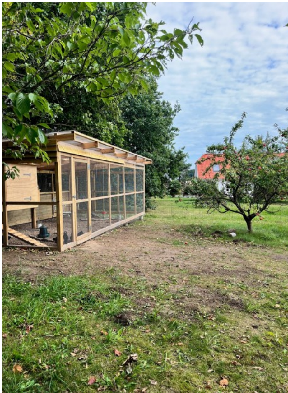
Figur 3. Viser den overdækkede hønsegård med hønsehus som er opført på ejendommen.
