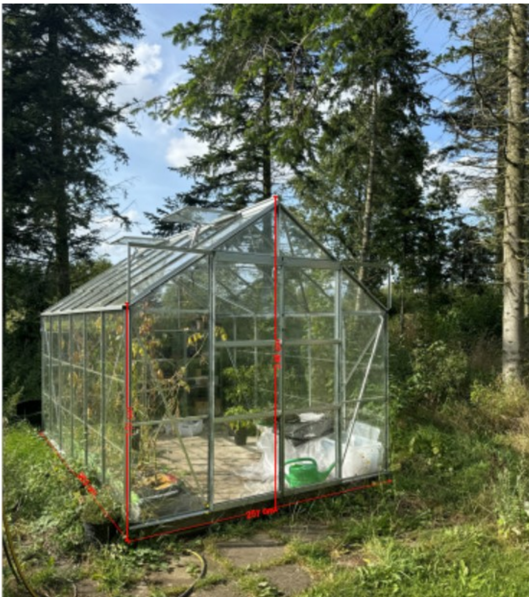
Figur 2. Viser drivhuset som er opført på ejendommen.
